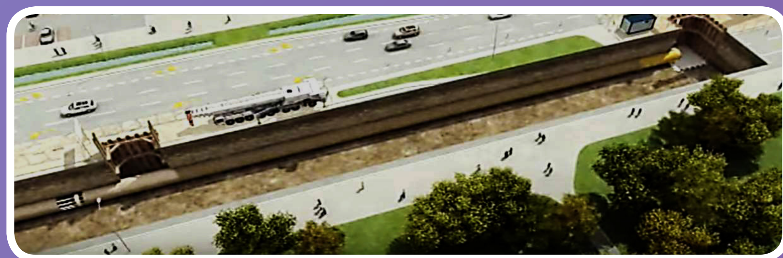
BURAKOWSKI-BIS SEWER PROJECT - Varsavia (Polonia) IMPLEMENTAZIONE DELLA RETE FOGNARIA: condotta di 3,2 km tramite la tecnica del microtunneling per la sicurezza ambientale e civile
