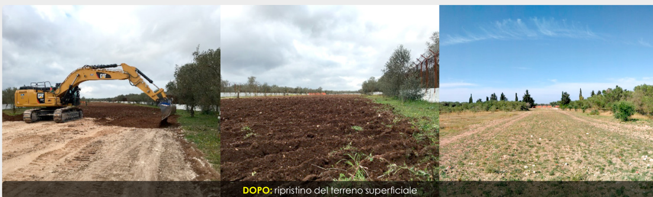
DURANTE: scavo della trincea e posa dei tubi
