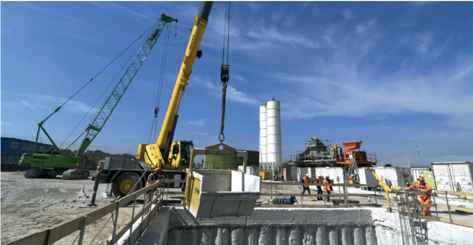
Cantiere del microtunnel, Melendugno (LE)
