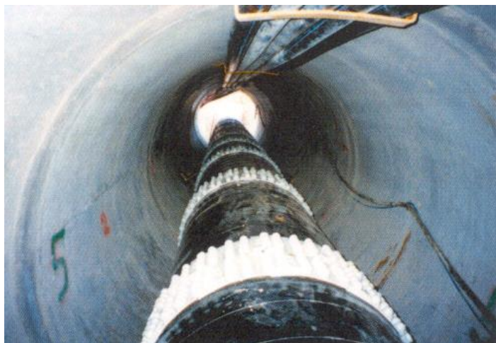
Figura 22: Condotta posata nel tunnel. Sono chiaramente visibili i distanziatori di plastica bianchi.
