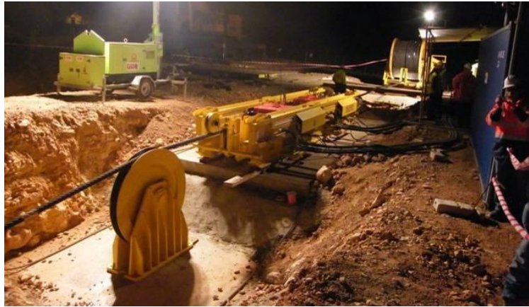
Figura 23: Tipico argano lineare per il tiro a terra.
