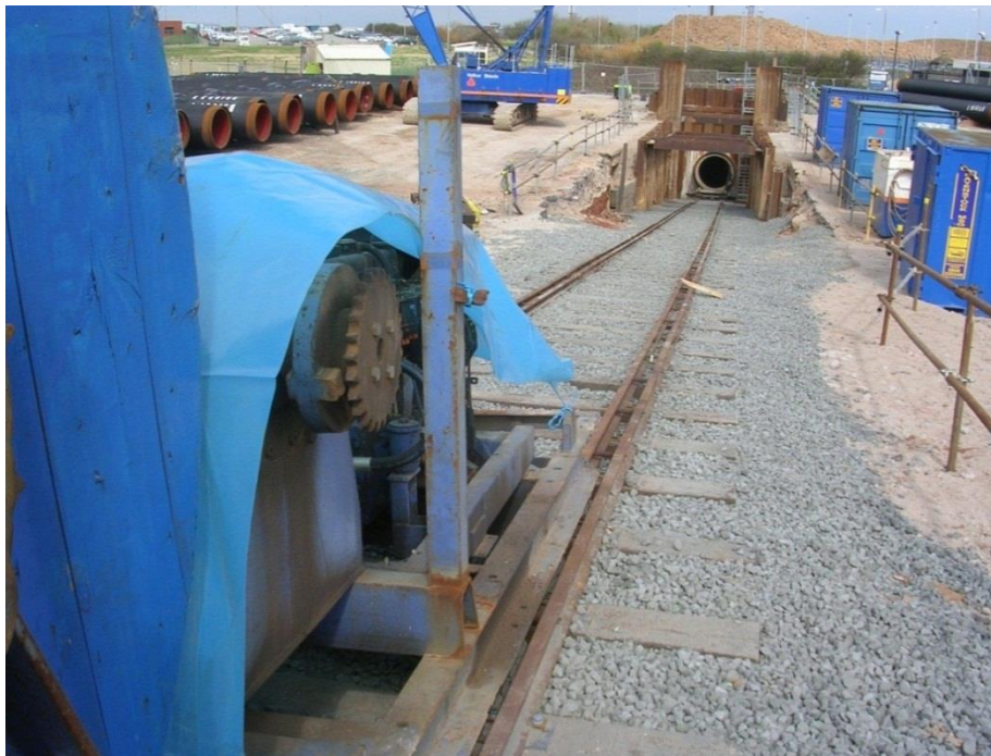
Figura 25: Foto di un collegamento tra argano e cavo di tiro realizzato nel punto di ingresso del microtunnel.
