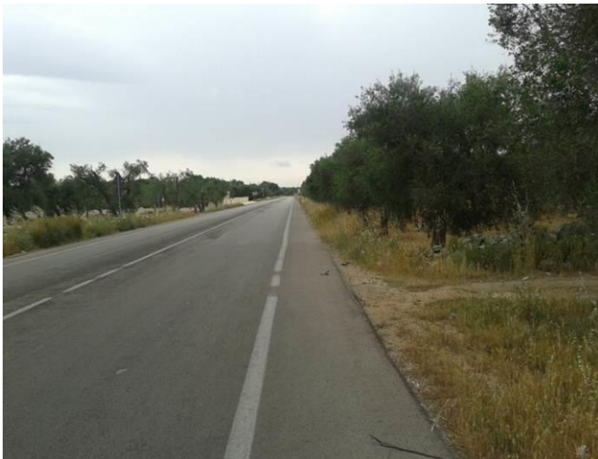
Foto n. 17 KP 6,4 Vista a est Attraversamento strada provinciale (trenchless)
